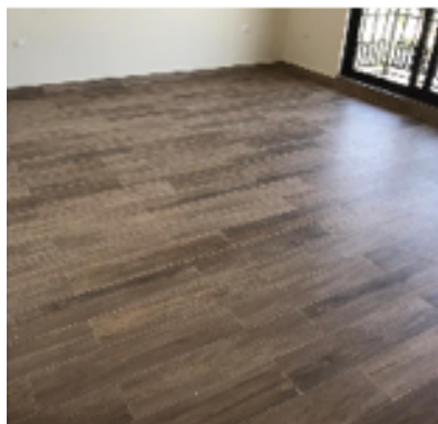
Lavado y pulido de piso laminado
