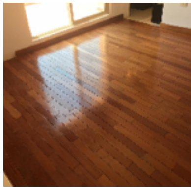
Aplicación de sellador a duelas
